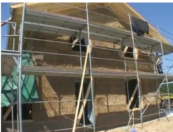
Imagen 8: Casa construida con fardos de paja / Fuente: Documental ``Redescubriendo un Material Antiguo``
