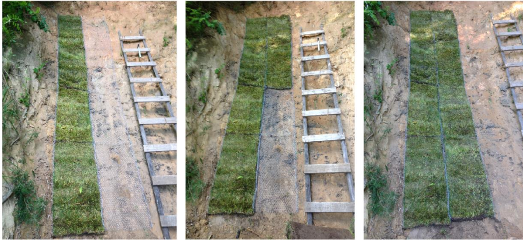
Figura G2: Instalación de la segunda franja.
