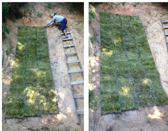
Figura G4: Instalación de la cuarta franja.
