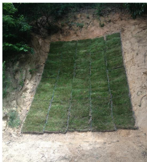
Figura G5: Instalación de la quinta franja.
