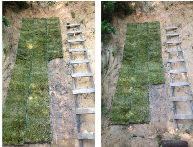
Figura G3: Instalación de la tercera franja.
