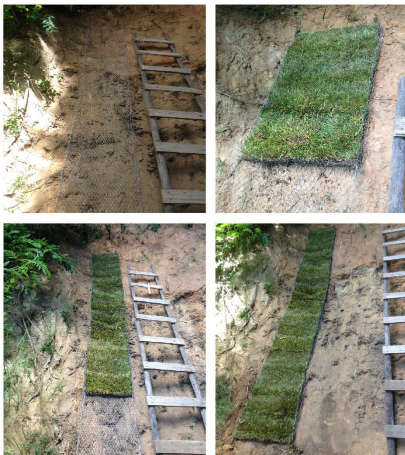
Figura G1: Instalación de la primera franja.
