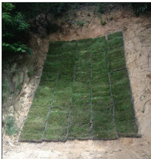
Figura 8. Sistema de recubrimiento instalado.
