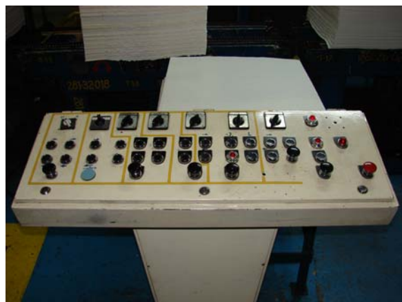
Fig. N°6: CP 20, control de cadenas transportadoras anteriores a la prensa de fardo.
