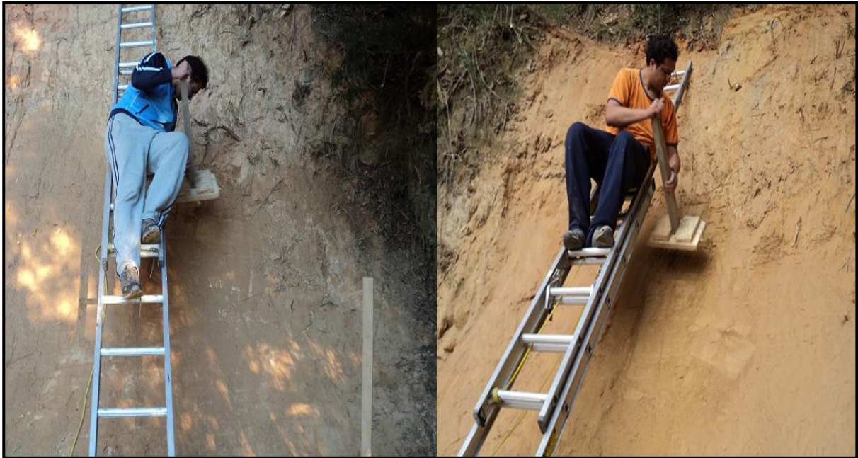
Figura J3: Etapas del proceso de compactación durante el reperfilado.
