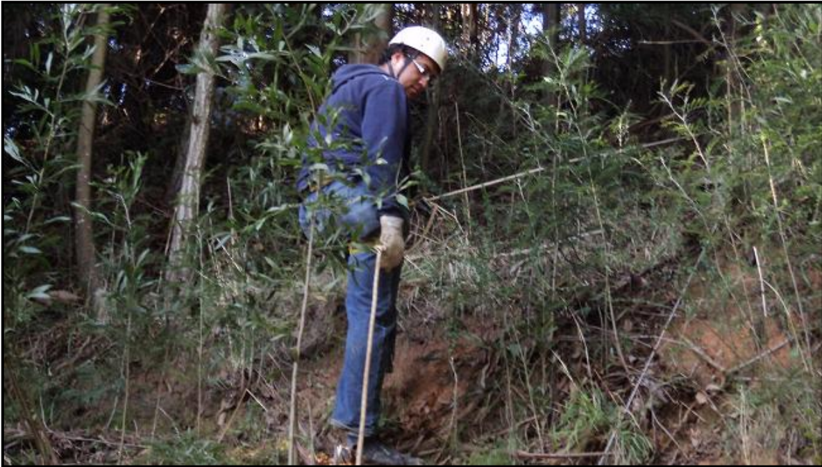
Figura J10: Instalación de cuerdas de seguridad previo al inicio de las mediciones.
