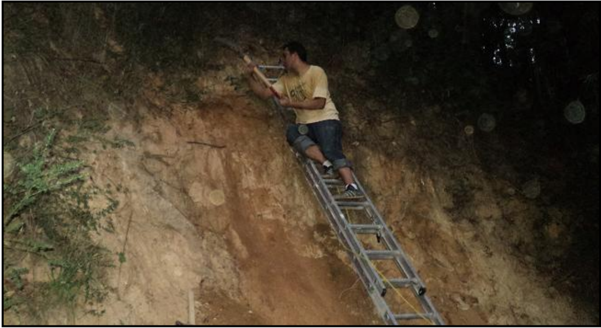
Figura J2: Corte y relleno de material durante el proceso de reperfilado de la superficie del talud.
