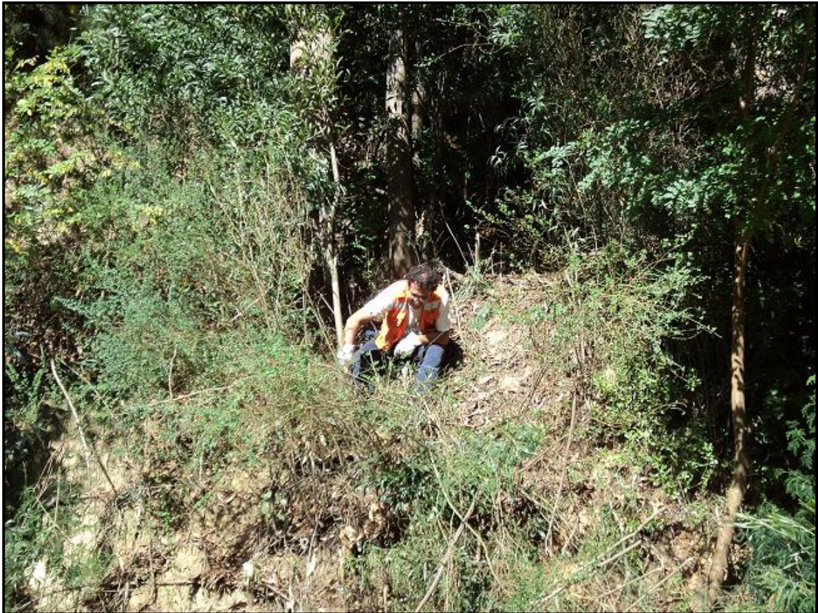
Figura J1: Realización de corte de maleza para delimitar zona de trabajo.
