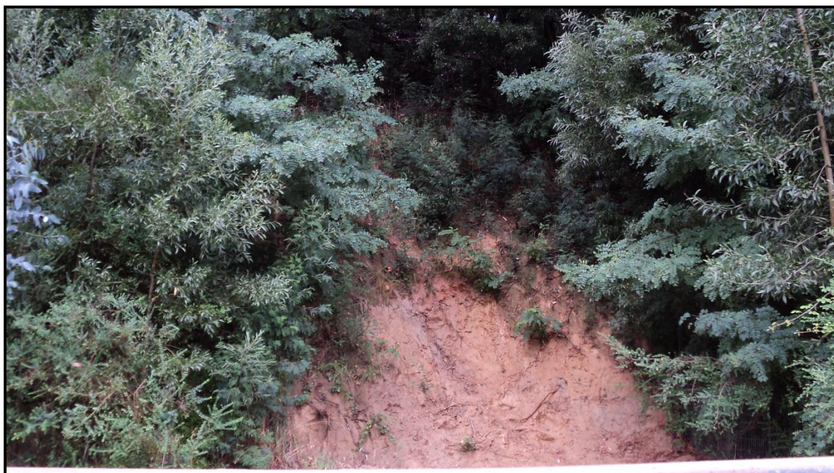
Figura C2: Situación base del talud existente en LAGEMA al interior del Campus Concepción de la UBB.
