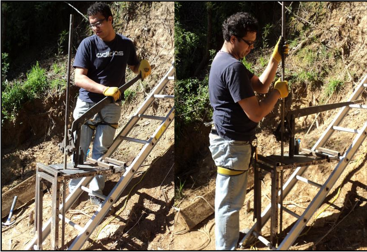
Figura J12: Retiro de barras luego de finalizado el sondaje en el punto muestreado.
