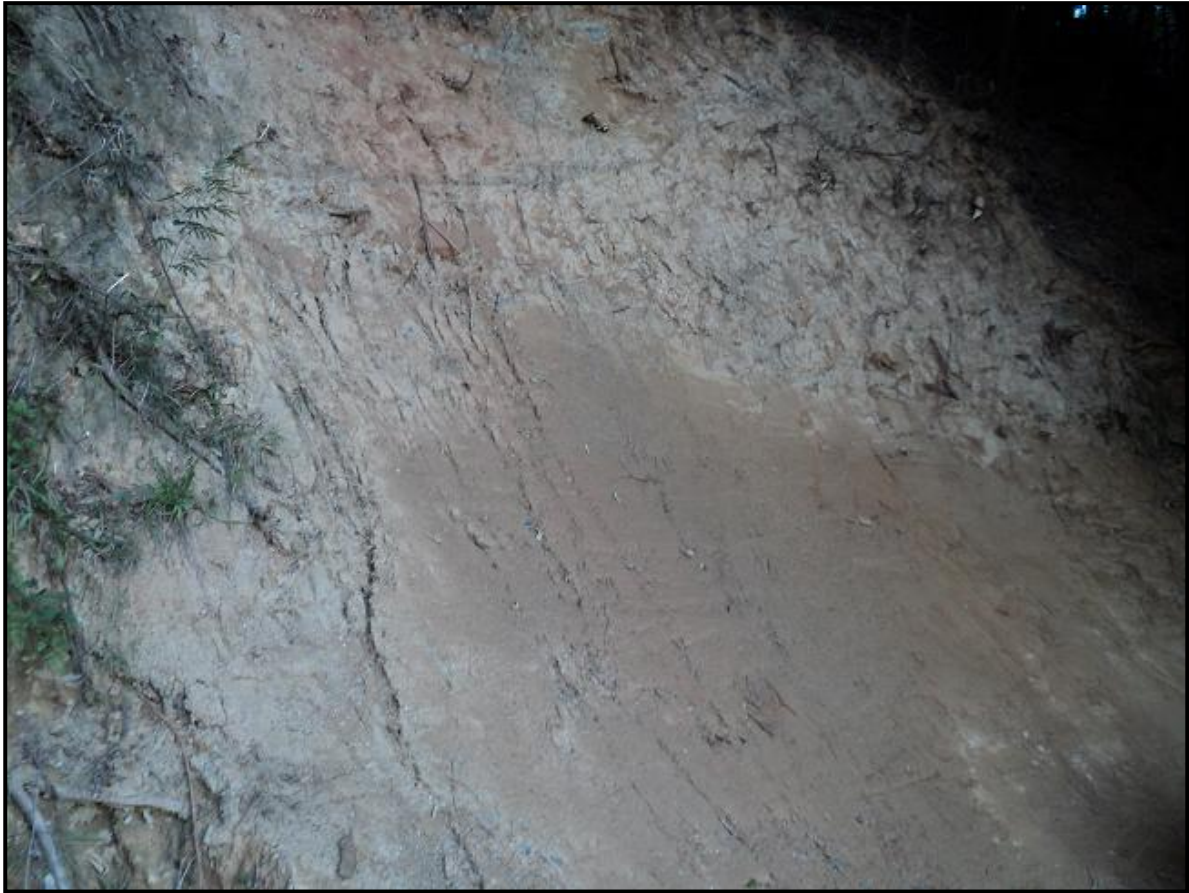
Figura C3: Estado final luego de reconstrucción de talud ubicado en LAGEMA al interior del Campus Concepción de la UBB.
