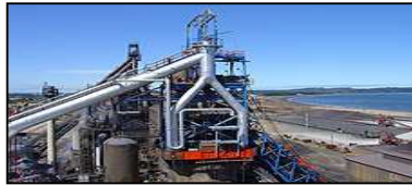
Fig. 1.3, Altos hornos, fuente: Huachipato
