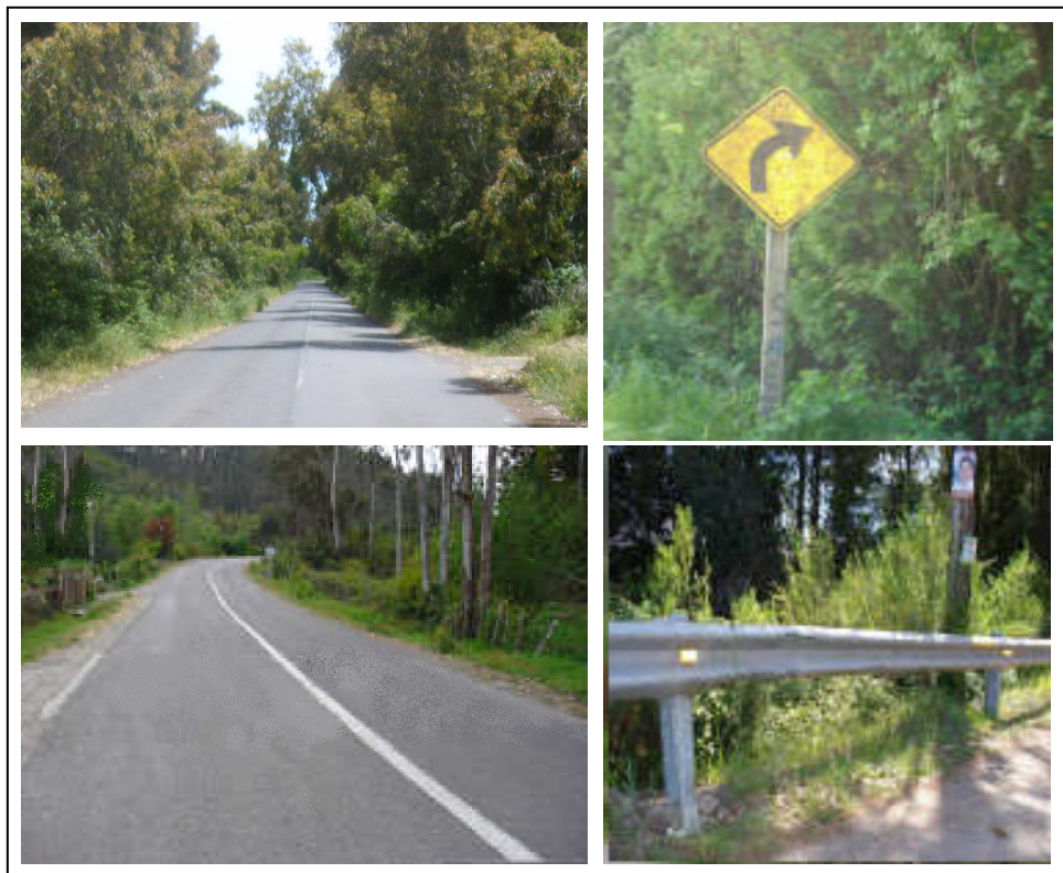
FIGURA 6.13. IMÁGENES ACTUALES DEL CAMINO PUENTE ÑUBLE – MONTELEON.
