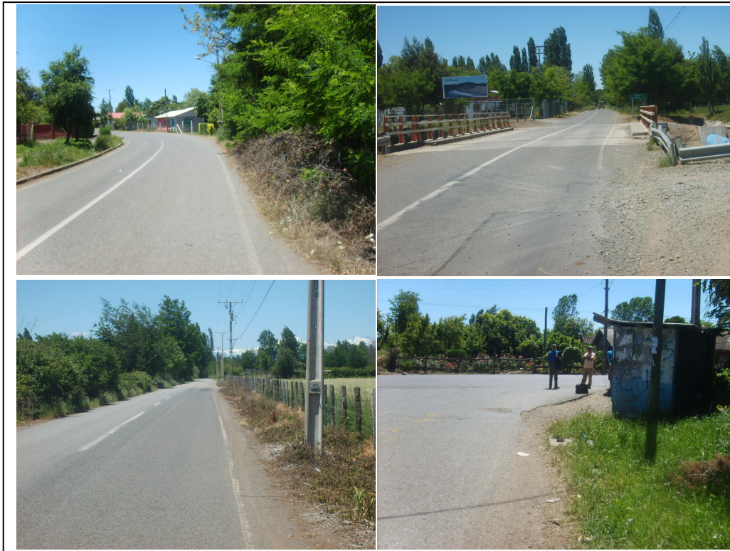
FIGURA 6.17. IMÁGENES ACTUALES DEL CAMINO PUENTE ÑUBLE – MONTELEON.
