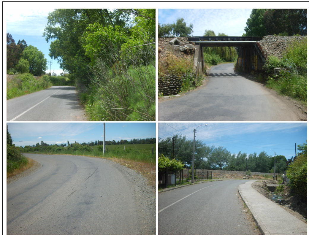
FIGURA 6.9. IMÁGENES ACTUALES DEL CAMINO PUENTE ÑUBLE – MONTELEON.
