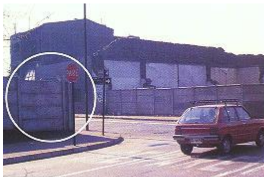
Figura F8. Muros.
