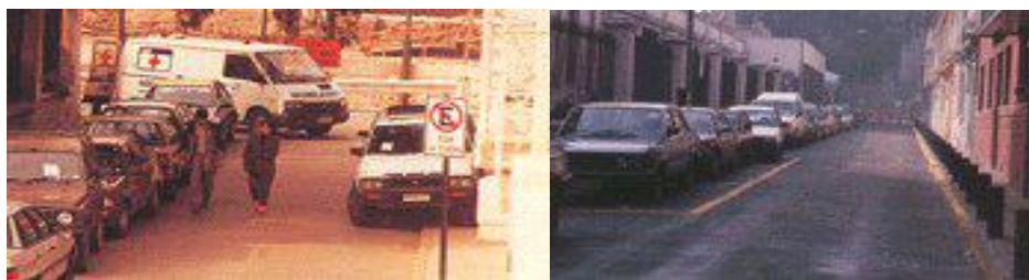
Figura F11. Antes y después de instalados los topes de contención.
