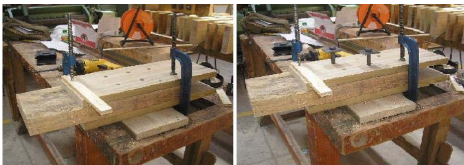
Figura B- 10: Colocación de pernos
