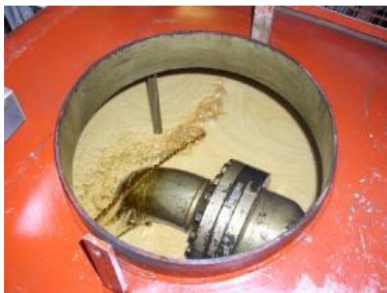
Figura N°2: Espuma en depósito de turbogenerador.
