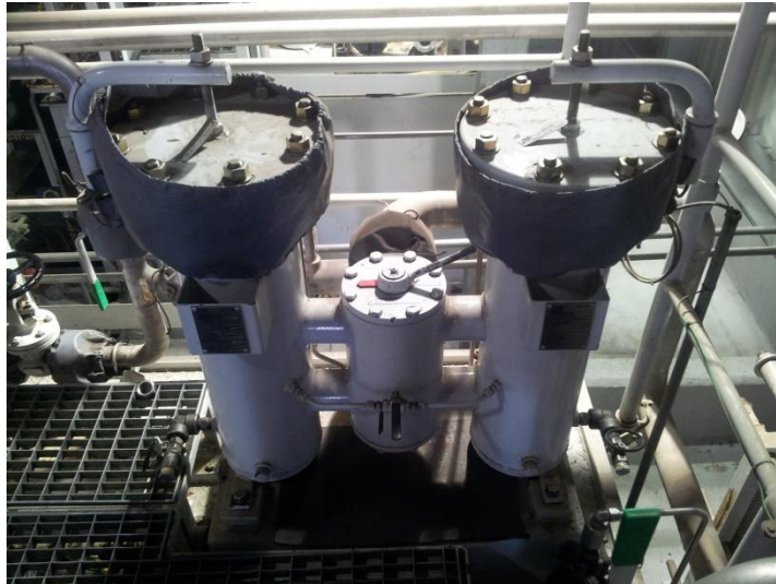
Figura 2-13: Filtros duplex de aceite lubricación.
