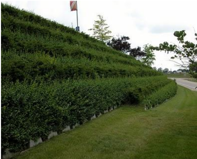
Figura 6: Talud protegido con una cobertura vegetal. (Fuente: http://www.urbanarbolismo.es/blog/?p=155 ).
