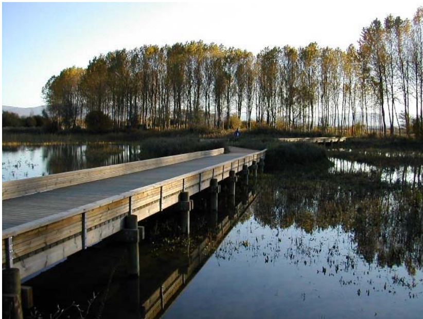
Figura N°2. Puentes “Sawn lumber beams” [Bibliografía N°29].
