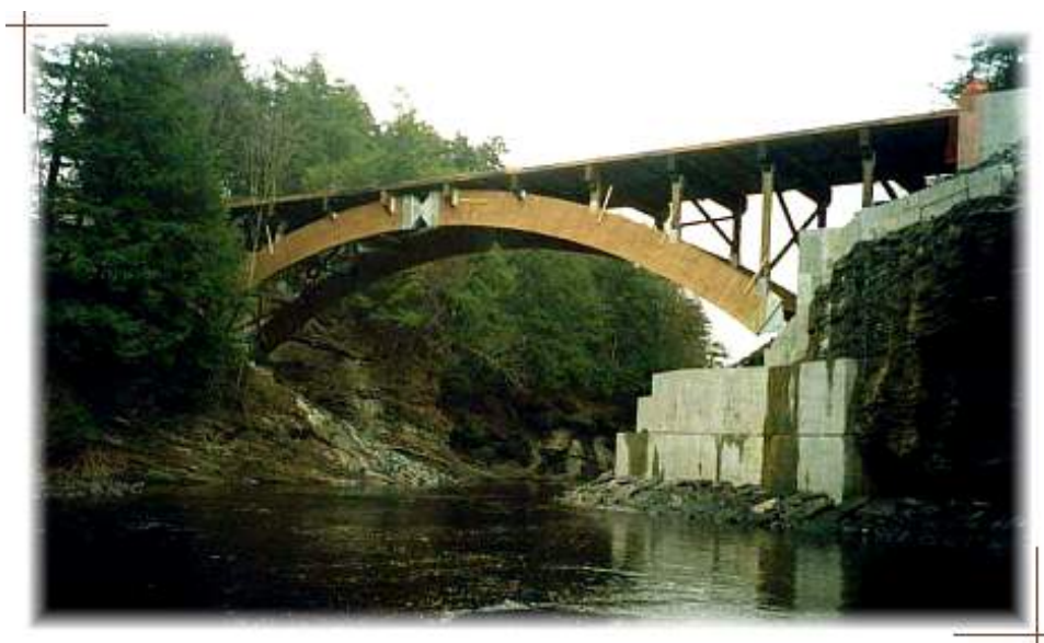
Figura N°3. Puentes “Glued-laminated timber beams” [Bibliografía N°31].
