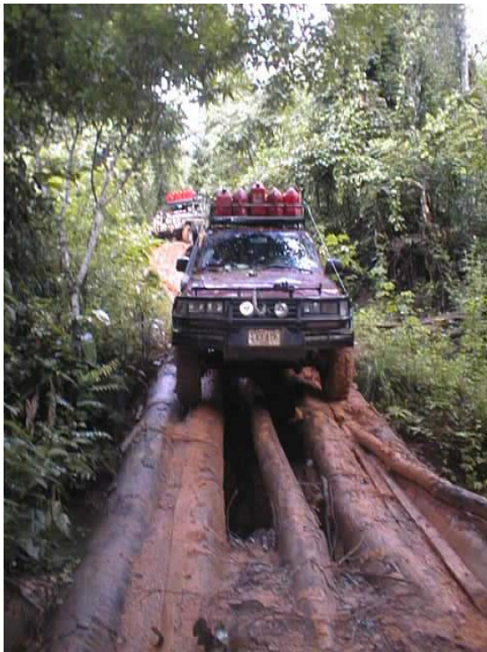
Figura N°1. Puentes “Log beams” [Bibliografía N°29].
