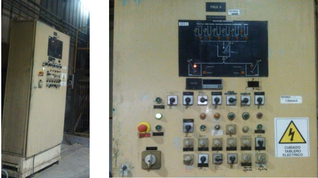
Figura 3. Fotografía exterior tablero de fuera y control proceso cocina cola
