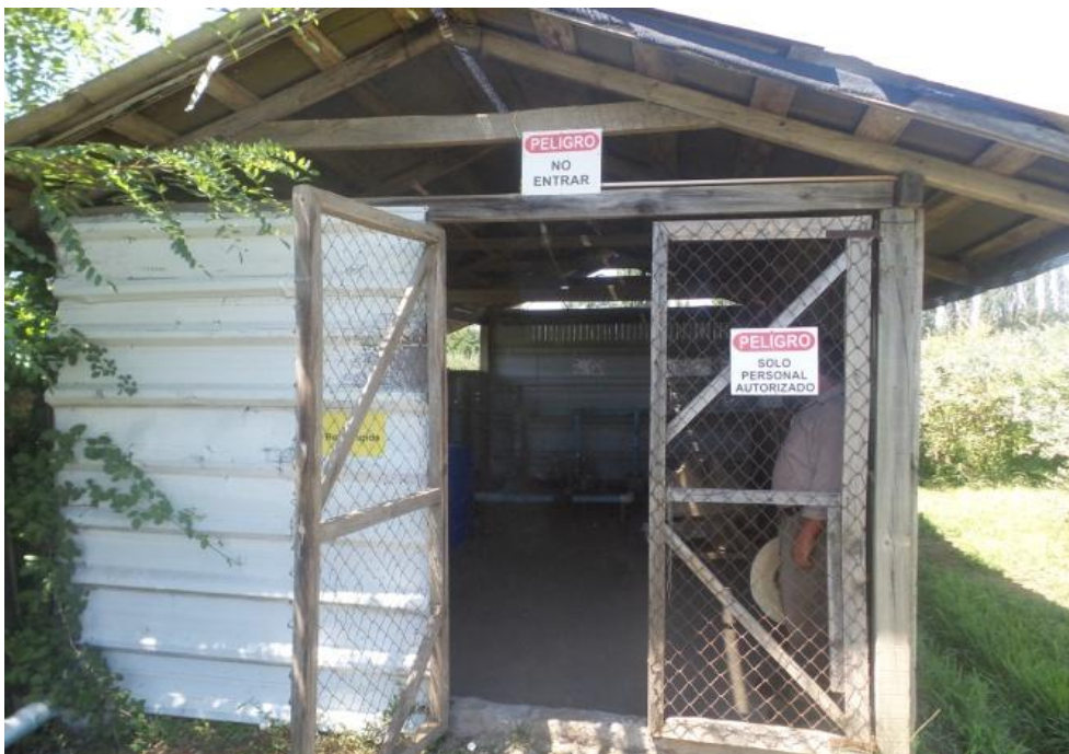
Fotografía 2.1 Sala de Máquinas.
