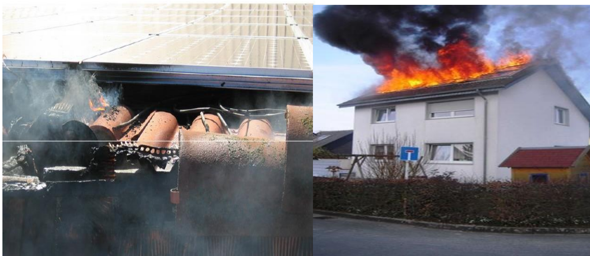
Figura 3.5 Daños asociados a una instalación fotovoltaica.
