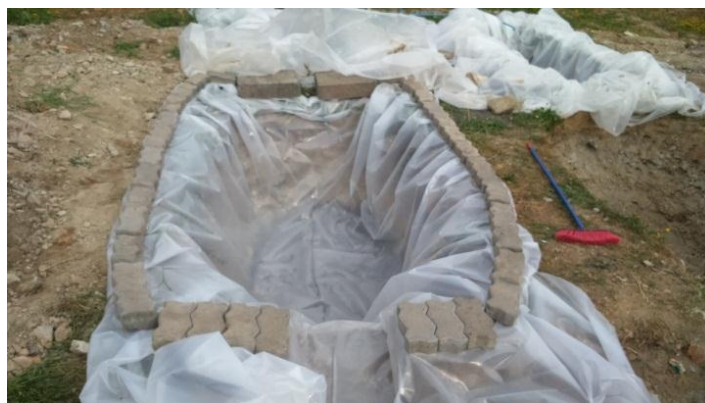
Figura A2: Impermeabilización de cuerpos receptores
