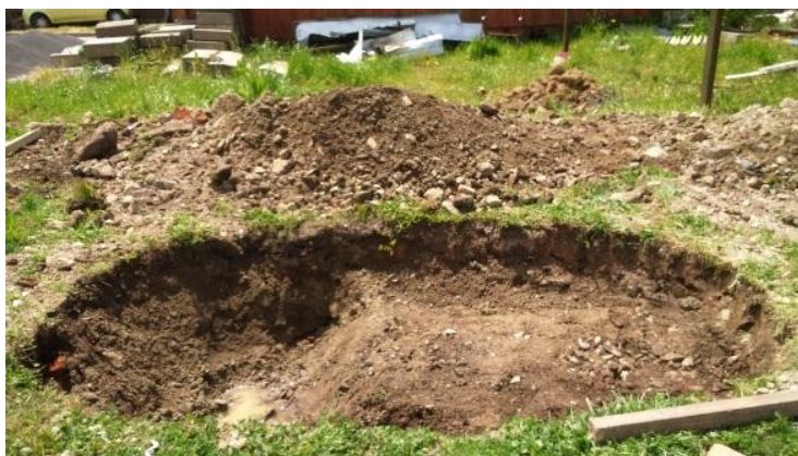
Figura A1: Excavación y nivelación de cuerpos receptores
