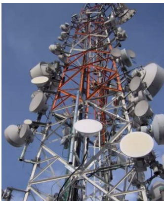
Figura 10. Torre con antenas direccionales parabólicas. Figura 11. Patrón Radiación Antena Parabólica
