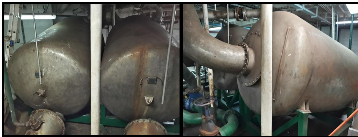
Imagen 4.3.a; Estanques de recepción
