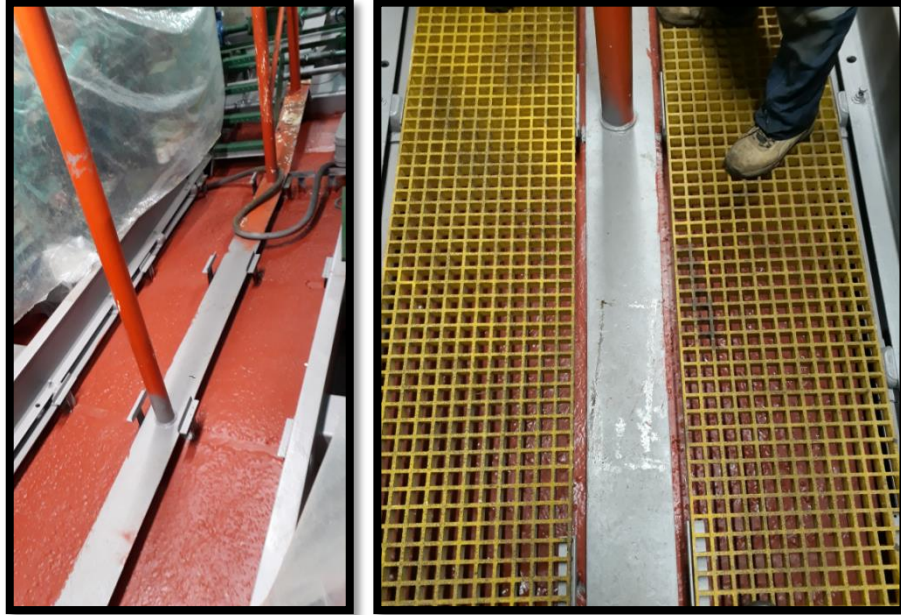
Imagen 6.1.b; Esquema tratamiento de pintura y nuevo grating
