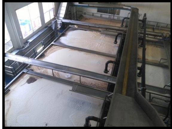
Imagen 1.4.b; Pozos de almacenamiento
