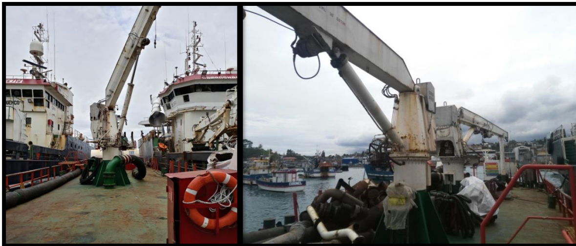
Imagen 4.4.a; Grúas hidráulicas popa N° 1 – proa N° 2
