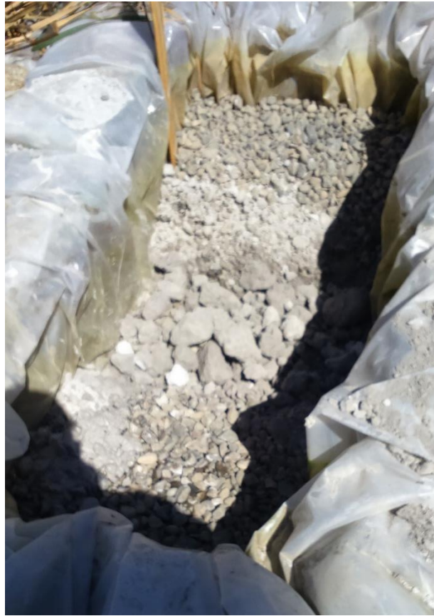
Figura B 4. Incorporación de óxido de calcio en humedal.
