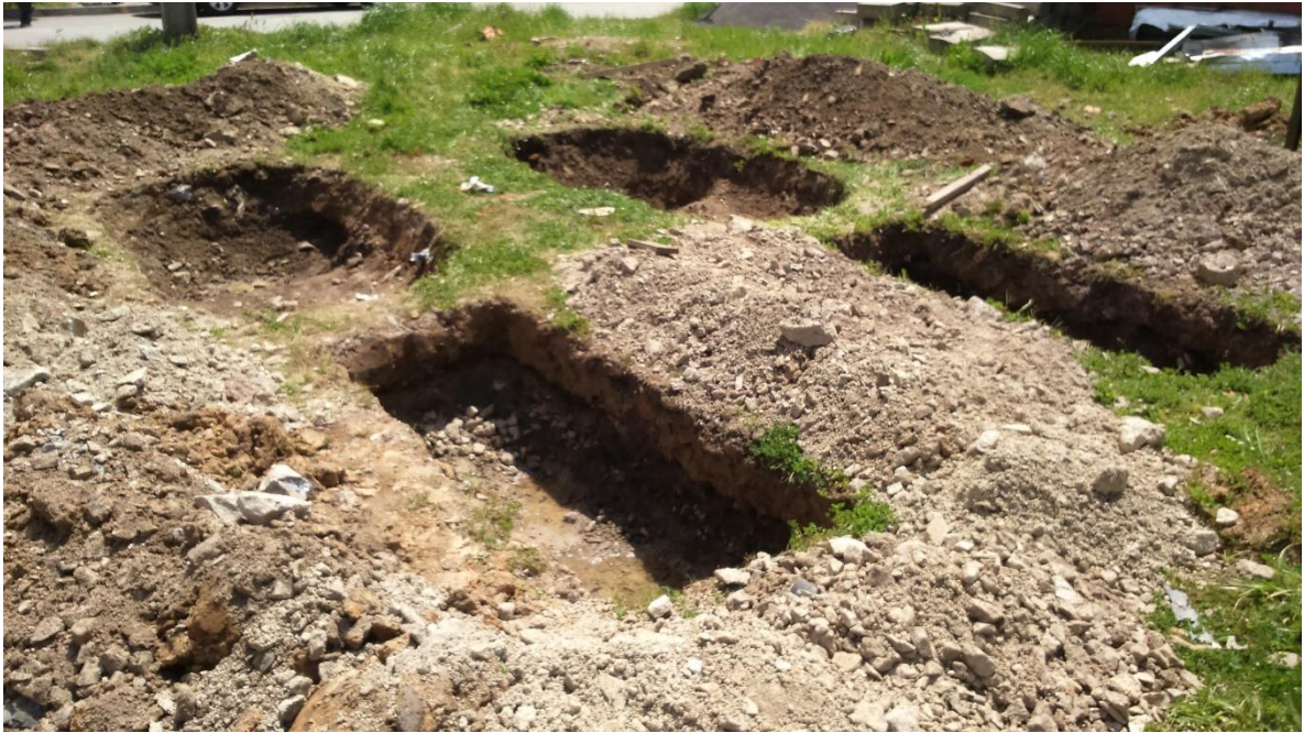
Figura B 7. Excavaciones construcción de los humedales.
