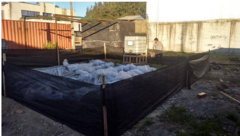
Figura B 10. Construcción definitiva de los humedales.
