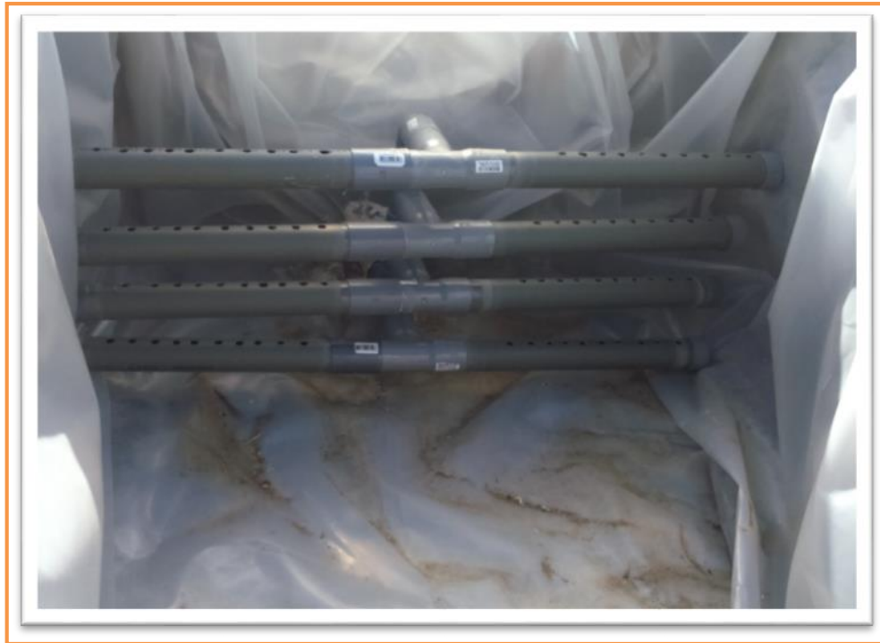
Figura 5. Dispositivo captación de efluente en el humedal.
