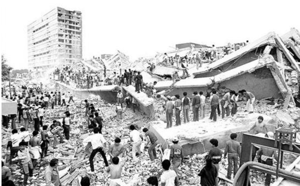
Figura 3. Edificio Nueva León en Tlatelolco, México tras el sismo de 1985.
