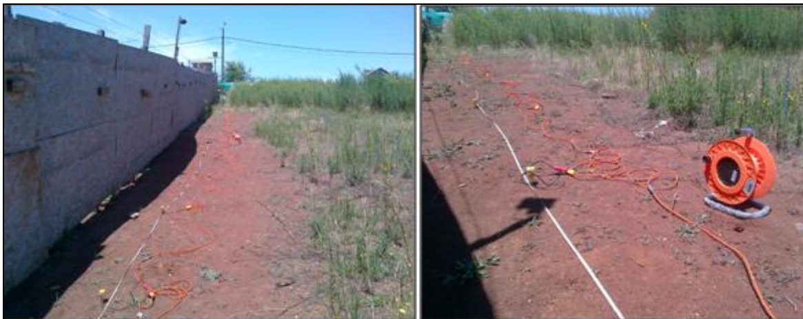
Figura 12. Fotos Ensayo in situ, Lomas de Bellavista, Concepción.
