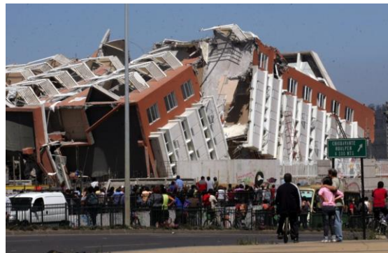
Figura N° 4 “Catástrofes edificio Alto Río, Concepción” (Fotografía extraída de la web)
