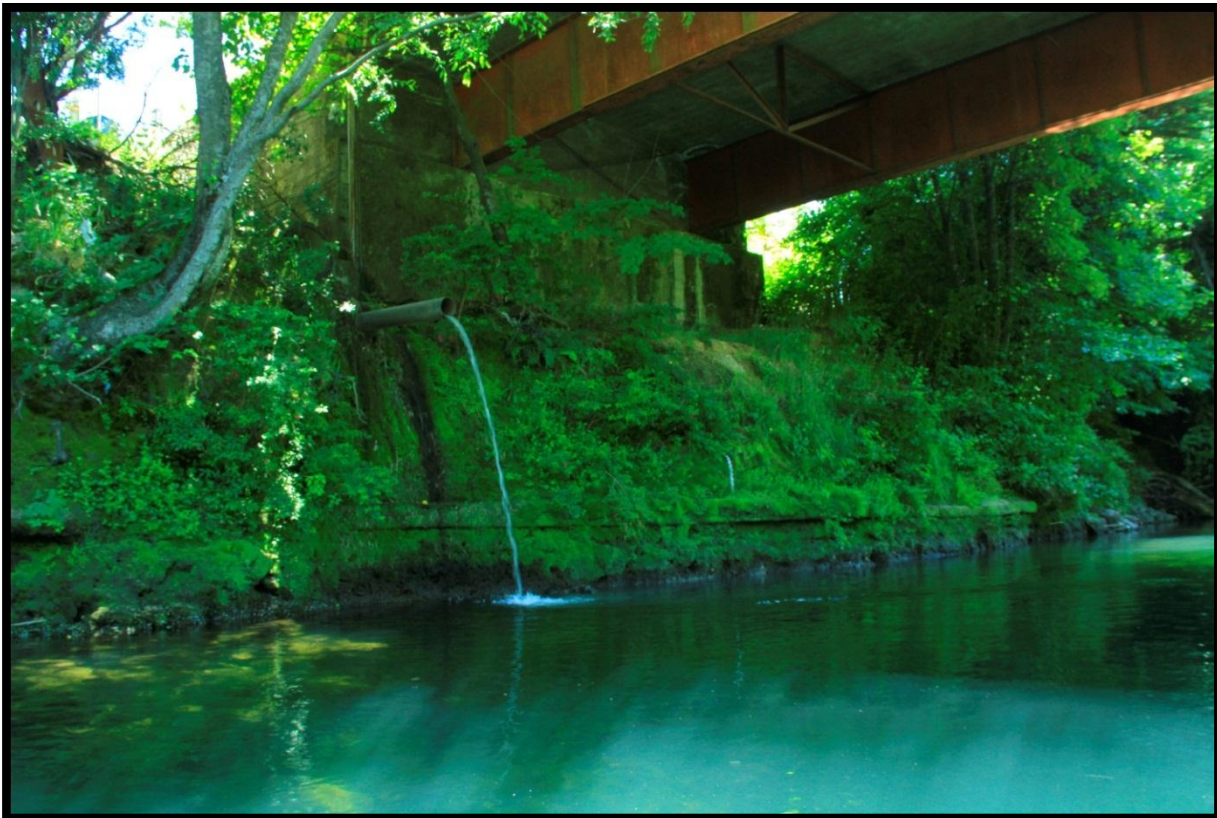
Imagen A.6, descarga de alcantarillado 6, puente Trancura
