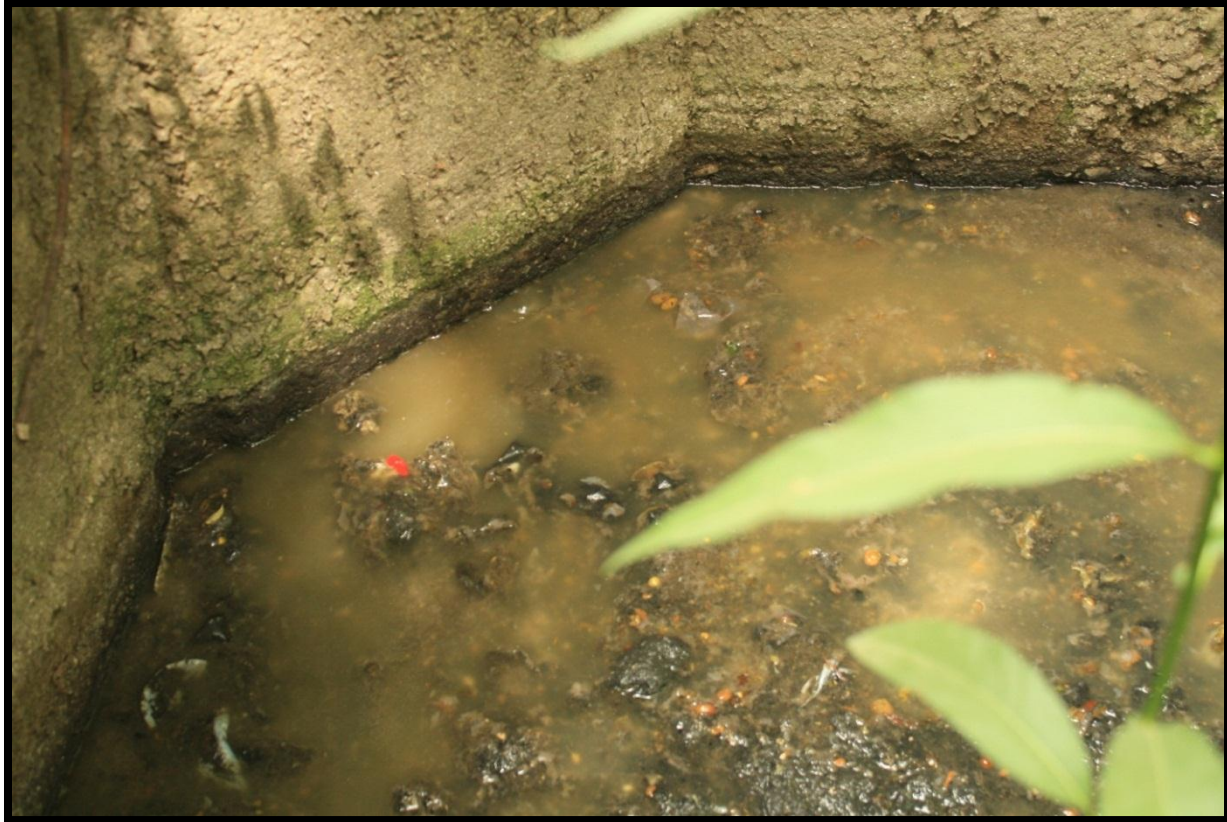
Imagen A.5, Descarga de alcantarillado 1
