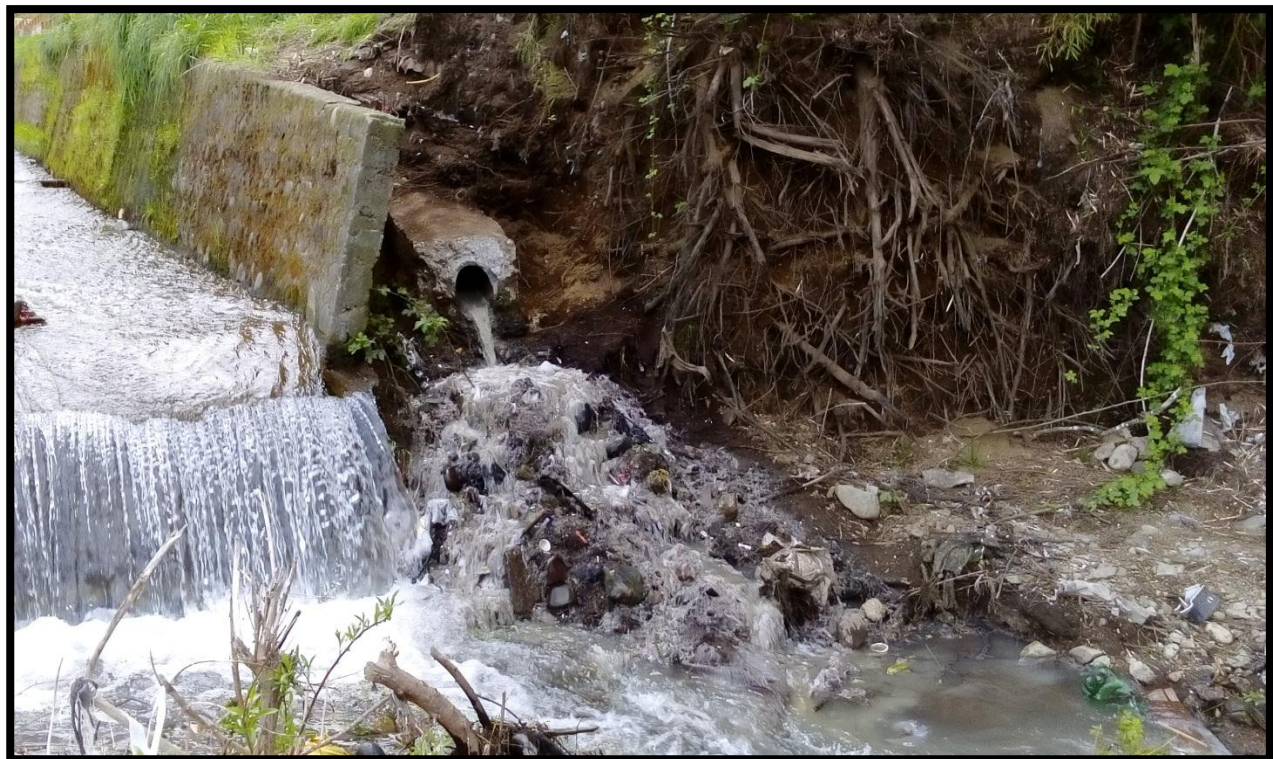
Imagen A.8, Descarga de alcantarillado 6, Estero Pulongo
