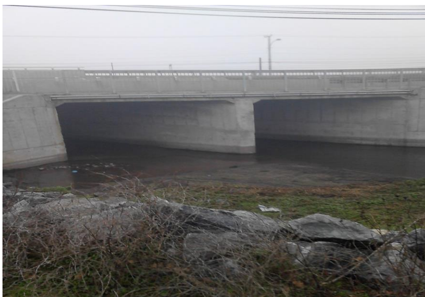
Figura A2. Paso superior Quilque, Avenida las Industrias cercano a la Estación Quilque. ( Fuente Elaboración Propia)
