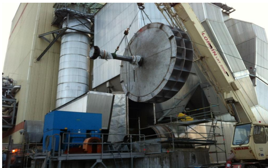
Figura 7.6, Izamiento de VTI
