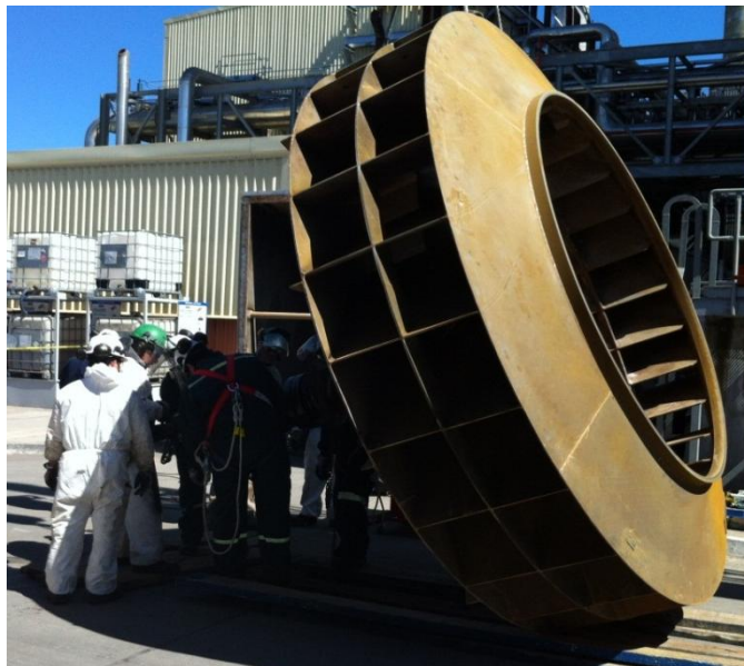
Figura 7.2, Ventilador tiro inducido caldera de poder número 4
