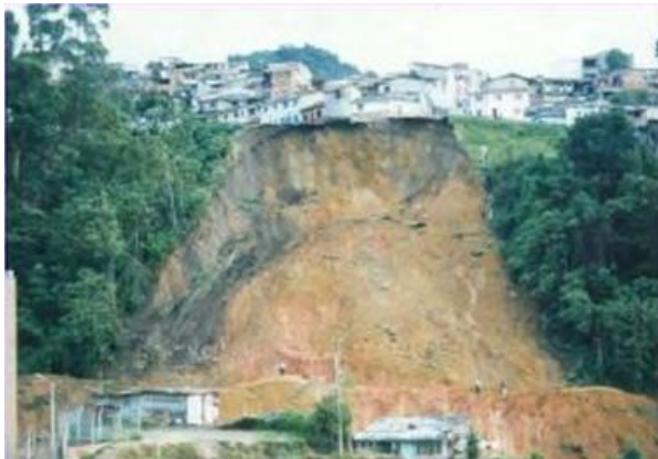
Figura N°7: Ejemplo Deslizamiento Tipo 2; Manizales, Colombia.-
