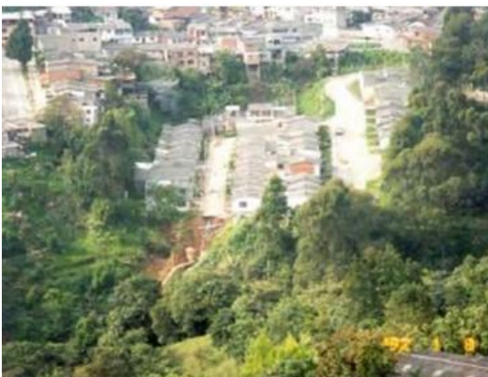
Figura N°8: Ejemplo Deslizamiento Tipo 4; Manizales, Colombia.-
