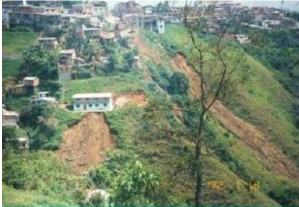
Figura N° 6: Ejemplo Deslizamiento Tipo 1; Manizales, Colombia.-
