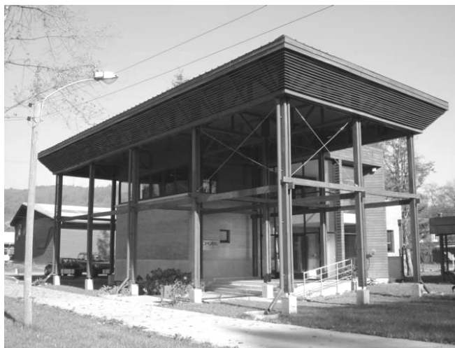
Figura 4.4. Fachada exterior Laboratorio CIMUBB.
