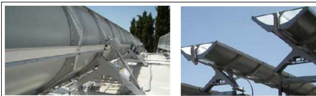
Figura 5.4: Actuadores de giro y bastidores de sujeción del colector X10 T
