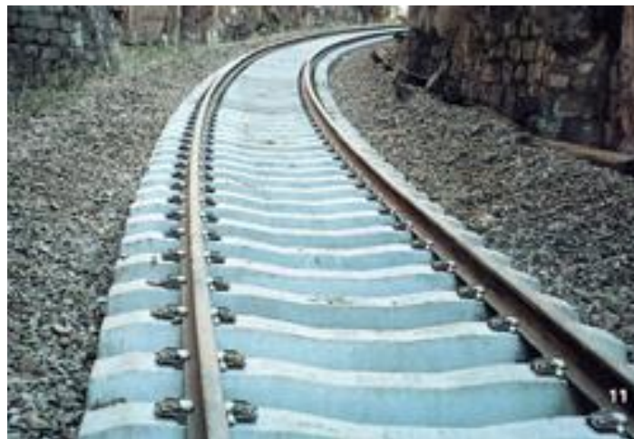
Fig. 2.15. Línea férrea con durmiénte de hormigón. 18
