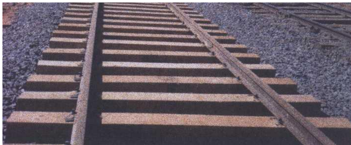
Fig. 2. 10 Vía férrea para un ferrocarril con durmientes de madera. 12
