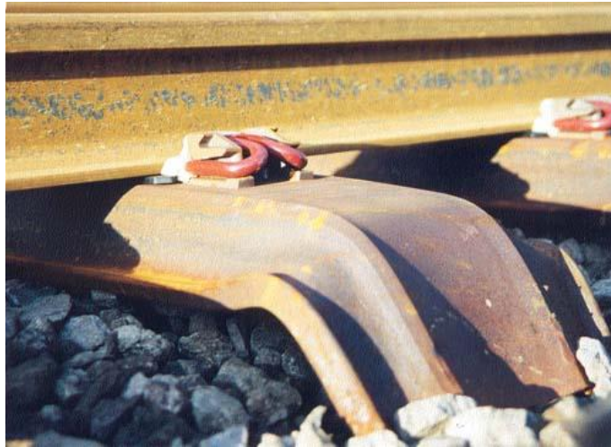
Fig. 2.12. Riel sobre durmiente metálico. 14
