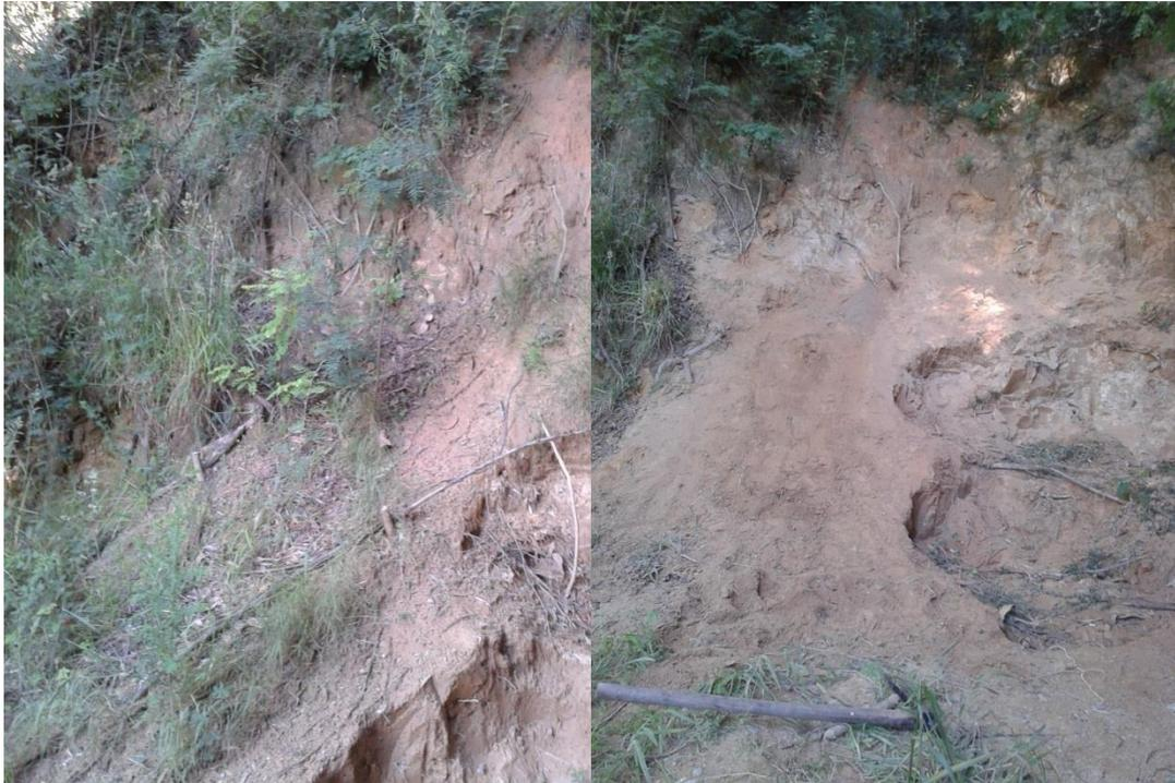
**Figura C5. Talud antes y después de limpieza con re perfilamiento.**
