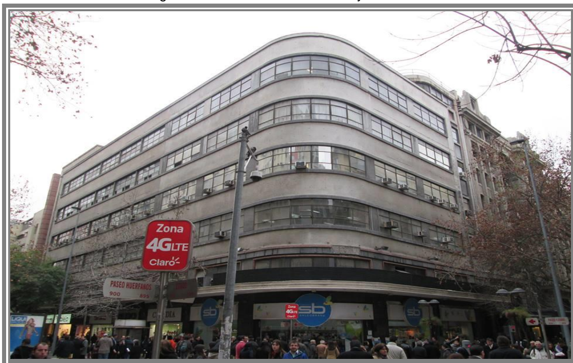
Figura. 26: Situación actual del Goyescas
