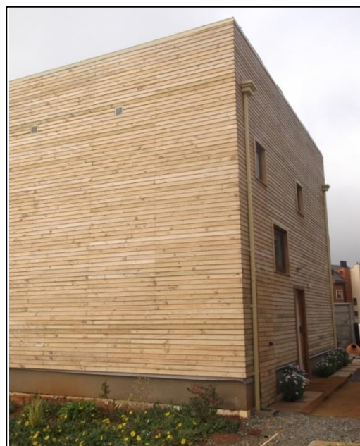
Figura 2.1 Prototipo FONDEF D09I1081: Vivienda pareada en madera sólida CLT Fuente: Hempel et al. 2013
