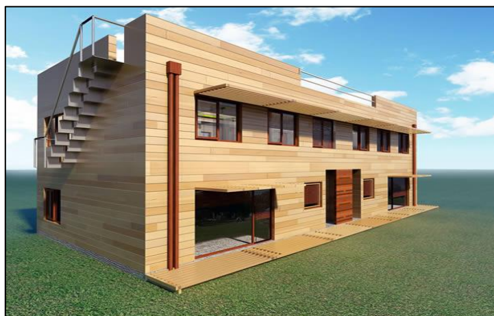
Figura 2.1 Prototipo FONDEF D09I1081: Vivienda pareada en madera sólida CLT Fuente: Hempel et al. 2013
