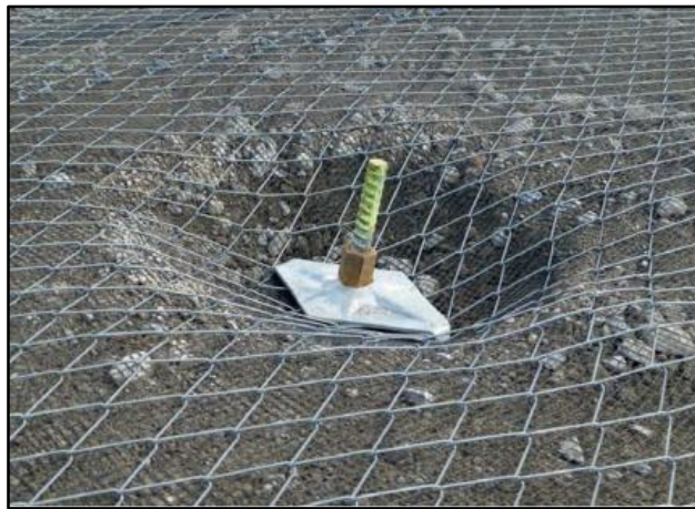
Fig. 5 Placa de fijación, pretensada, con cabeza de perno y malla (Fuente: Geobrugg, 2012)
