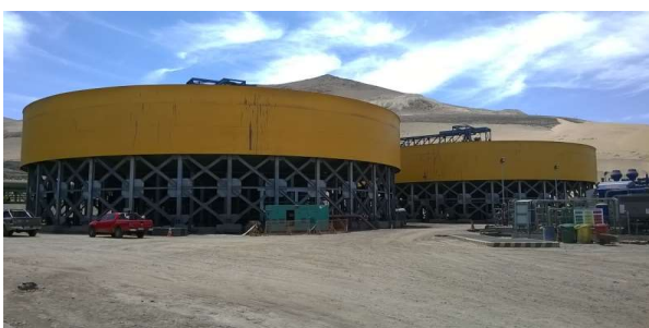
Figura A2, Estanque y Soportación.
