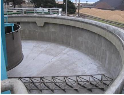
**Figura 3:** Estanque clarificador vacío.
