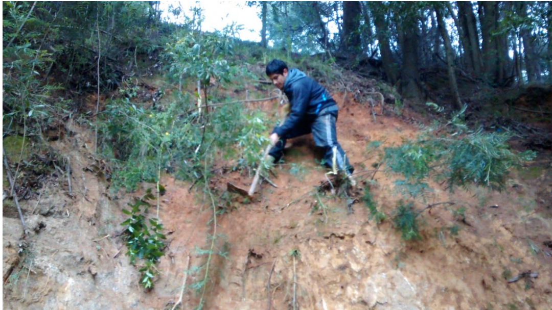
Figura G.2: Perfilamiento talud. (Fuente: Elaboración propia).
