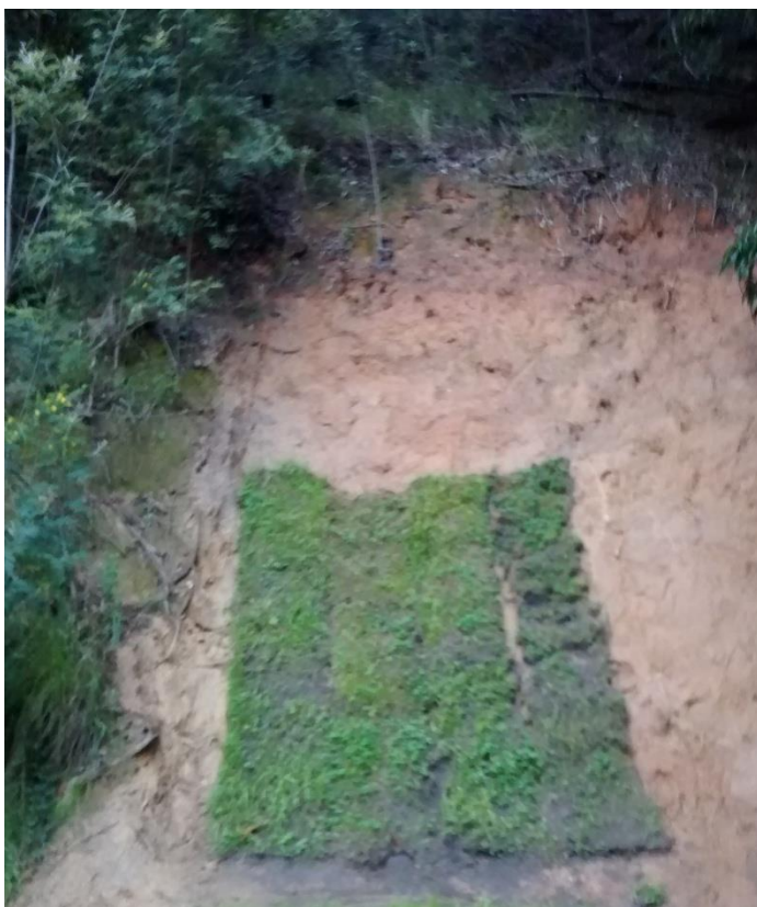
Figura 7: Mantos y tepes armados instalados. (Fuente: Elaboración propia).
