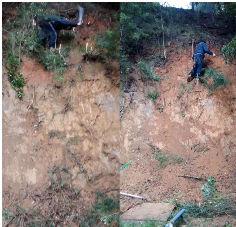
Figura G.1: Limpieza talud. (Fuente: Elaboración propia).
