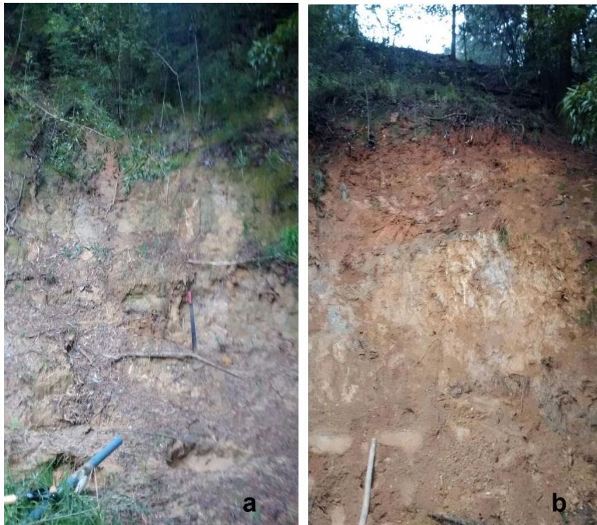
Figura G.3: a) Talud en condiciones naturales; b) Talud tras limpieza. (Fuente: Elaboración propia).
