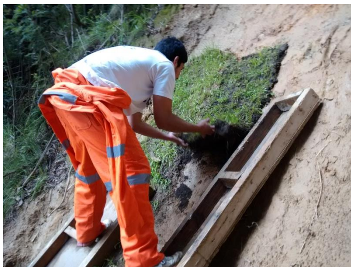
Figura G.5: Instalación de tepe en zona alta del talud. (Fuente: Elaboración propia).
