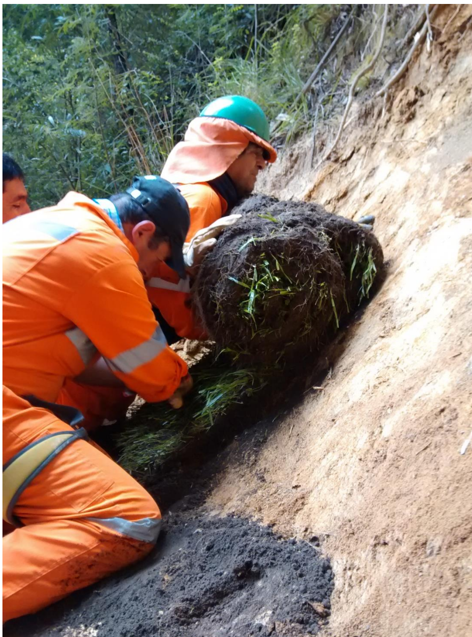
Figura G.4: Instalación del primer manto armado con malla metálica. (Fuente: Elaboración propia).
