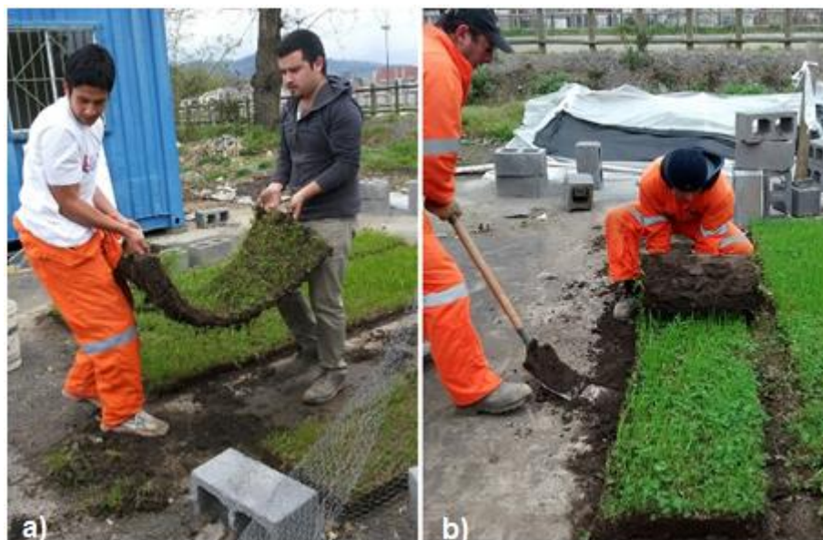
Figura 6: a) Traslado de tepe de césped armado con malla hexagonal; b) Enrollamiento de manto de césped armado con malla hexagonal. (Fuente: Elaboración propia).
