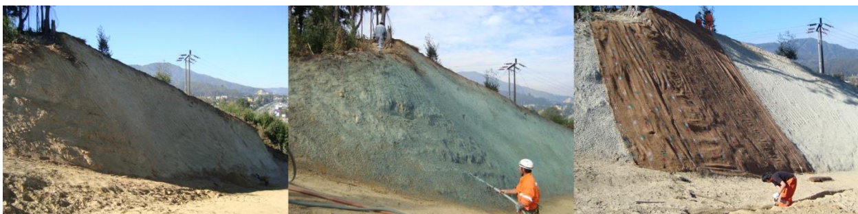
Figura B.4. Etapa hidrosembado. (Fuente: empresa especialista, 2012).
