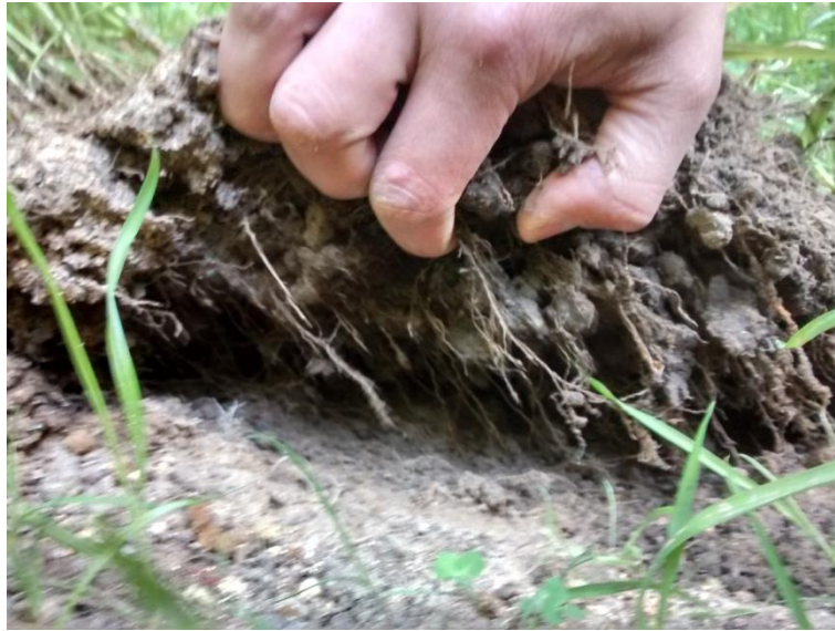
Figura G.9: Enraizado a los 20 días de la instalación del recubrimiento sobre el talud, ha comenzado el enraizamiento. (Fuente: Elaboración propia).
