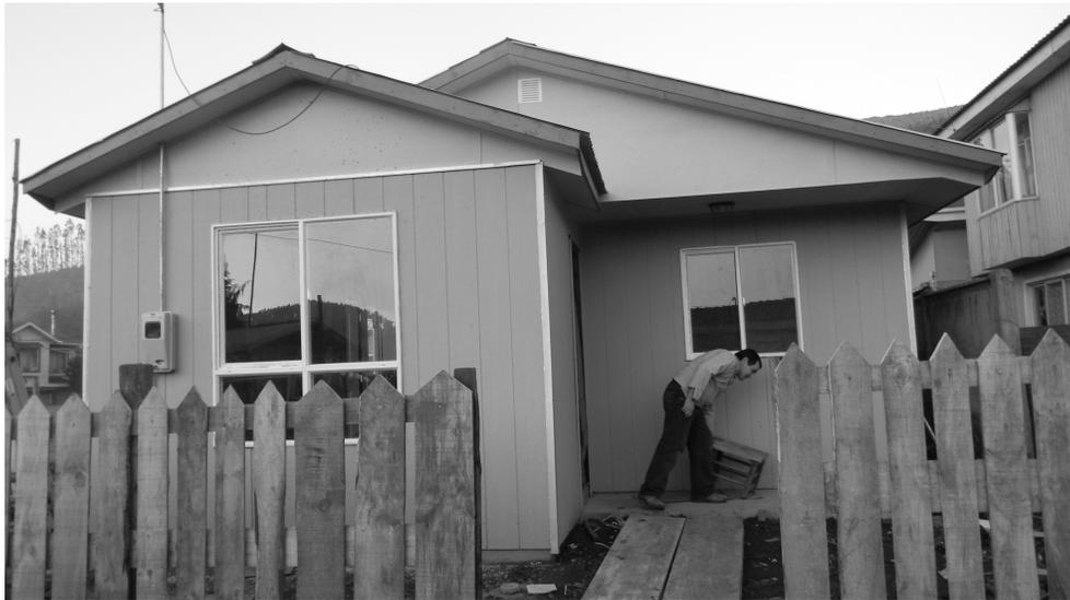
**Figura 27: Fotografía de vivienda de entramado en madera**
