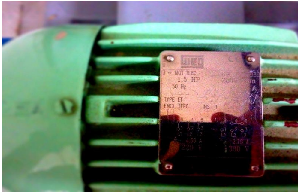
Fotografía 6-2: Placa de datos del motor.
