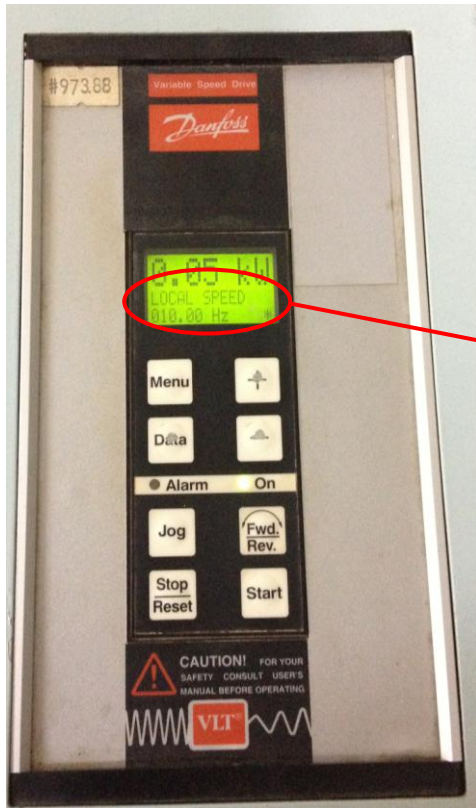
Fotografía 6-10: Variador de Frecuencias programado para trabajar a 10 Hz.
