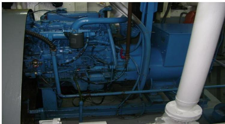
Figura 4.24: Motor Hyundai GM4AK del pontón Ártica.
