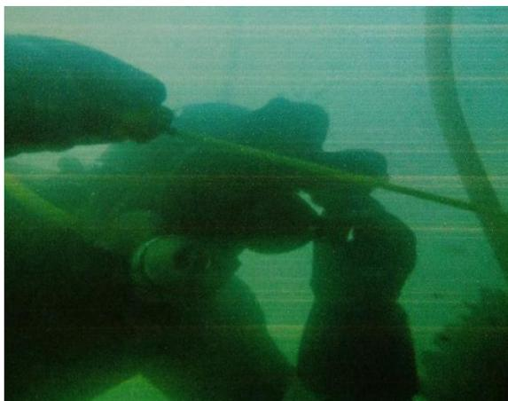
Figura 4.3: Instalando ánodos de zinc bajo mar para el pontón Ártica.
