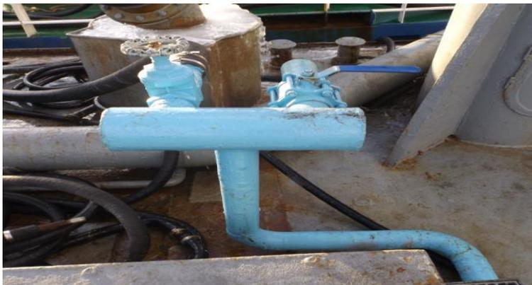
Figura 4.33: Manifold dentro del pontón Ártica.
