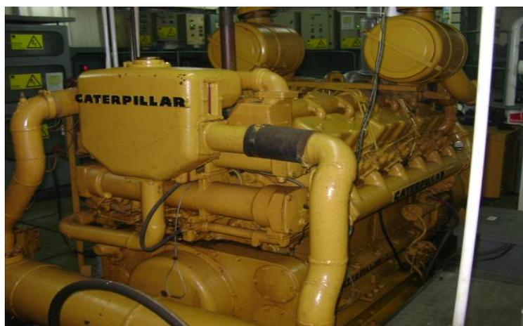
Figura 4.20: Motor generador D398 dentro del pontón Ártica.
