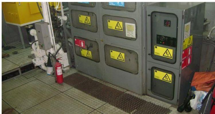
Figura 4.23: Tablero eléctrico dentro del pontón Ártica.
