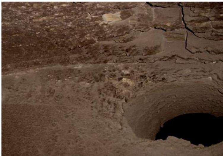
*Figura 4.2 Desprendimiento de ladrillos refractarios del antehogar de la caldera.*
