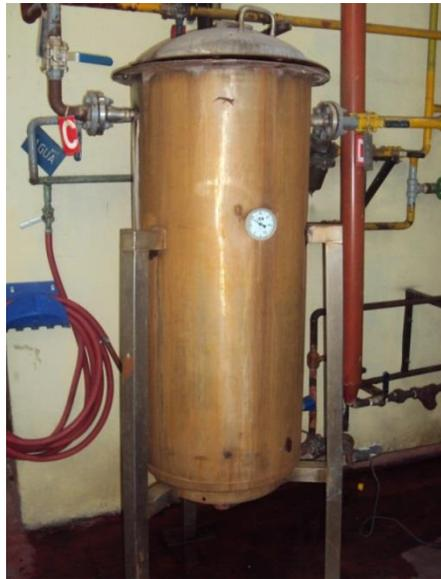
*Figura 2.25 Gasificador de CO<sub>2</sub>.*
