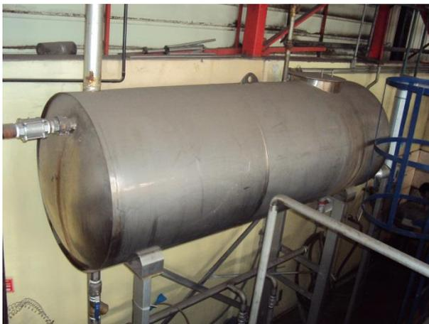
*Figura 2.13 Acumulador de retorno de condensado.*
