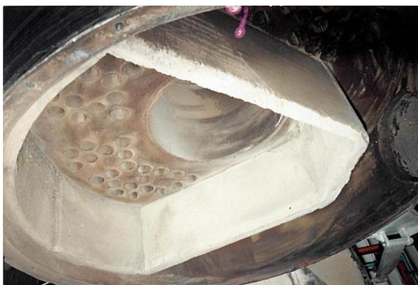
*Figura 2.10 Zona de radiación y convección (tubos)*
