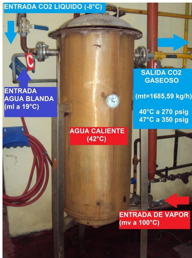
Figura 3.1 Esquema del proceso del gasificador.
