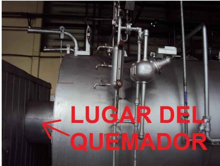
*Figura 6.2 lugar de instalación del quemador*
