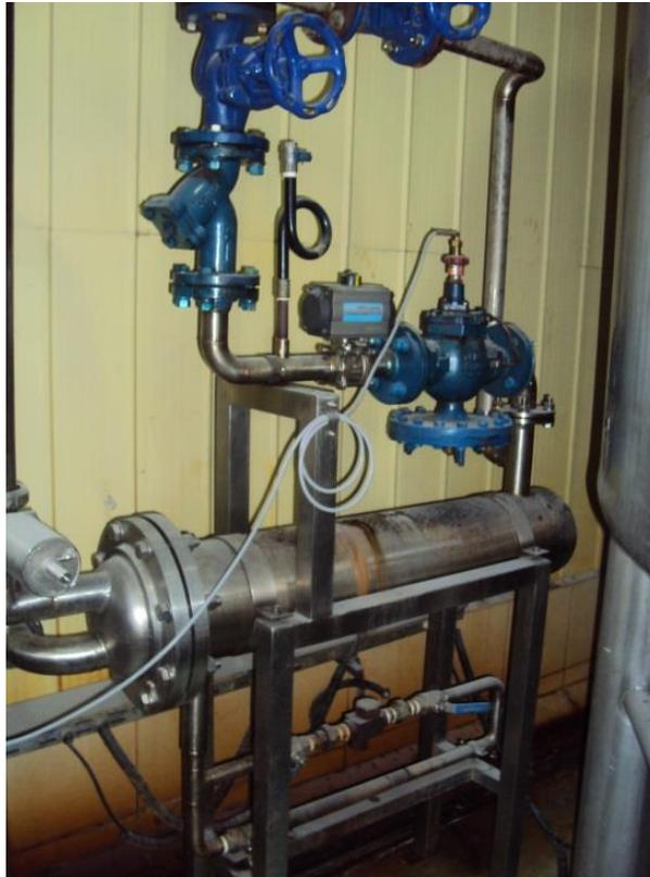
*Figura 2.23 Intercambiador de calor.*
