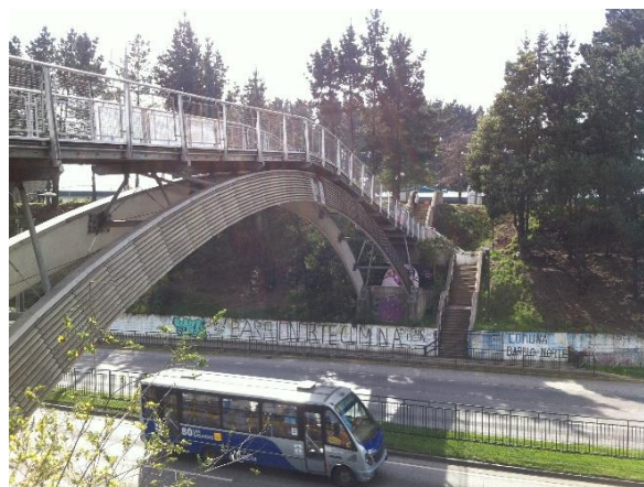
Figura 2. Vista sur de la pasarela
