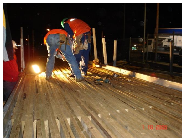
Figura 3. P constructivo (b) Montaje de la placa
