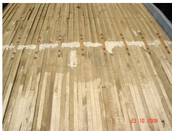
Figura 3. P constructivo (d) Uniones de la placa
