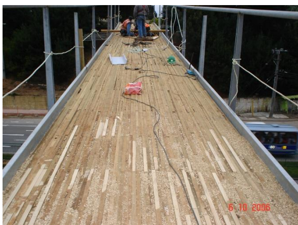
Figura 3. P constructivo (c) Placa montada
