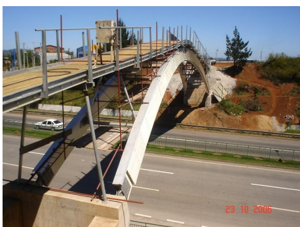
Figura 3. P constructivo (e) Instalación de la baranda
