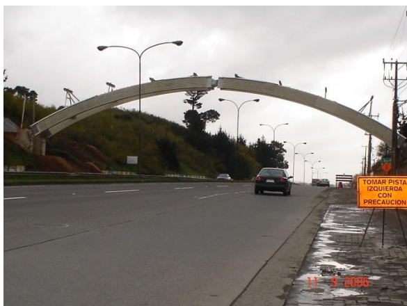
Figura 3. P constructivo (a) Arcos montados
