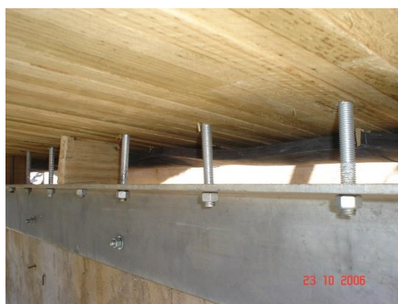
Figura 3. P constructivo (f) Unión placa y marcos
