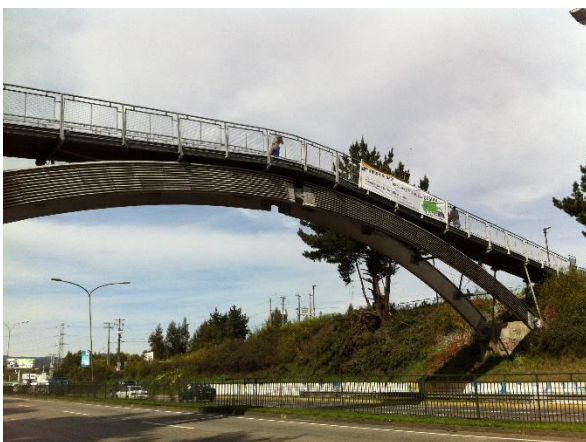
Figura 1. Vista norte de la pasarela
