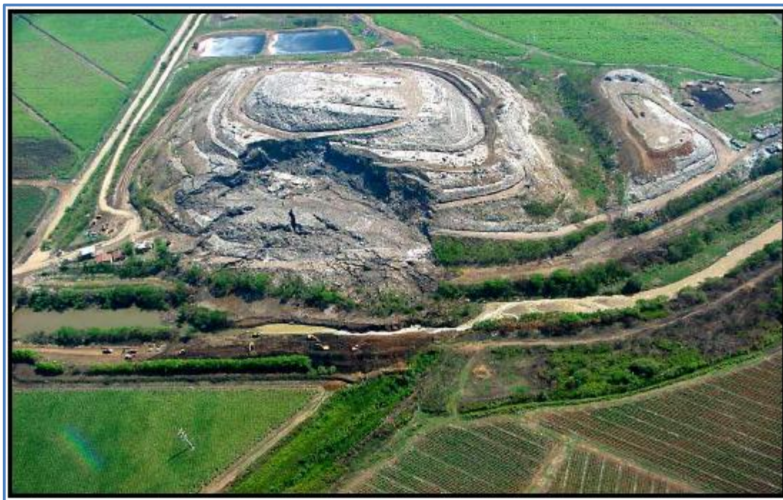
Figura D3. Falla circular relleno sanitario “Navarro” en Cali, Colombia. Fotografía tomada 13 de Septiembre del 2001
