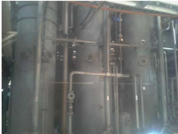
Fig.2.10. Planta elevadora triple efecto.
