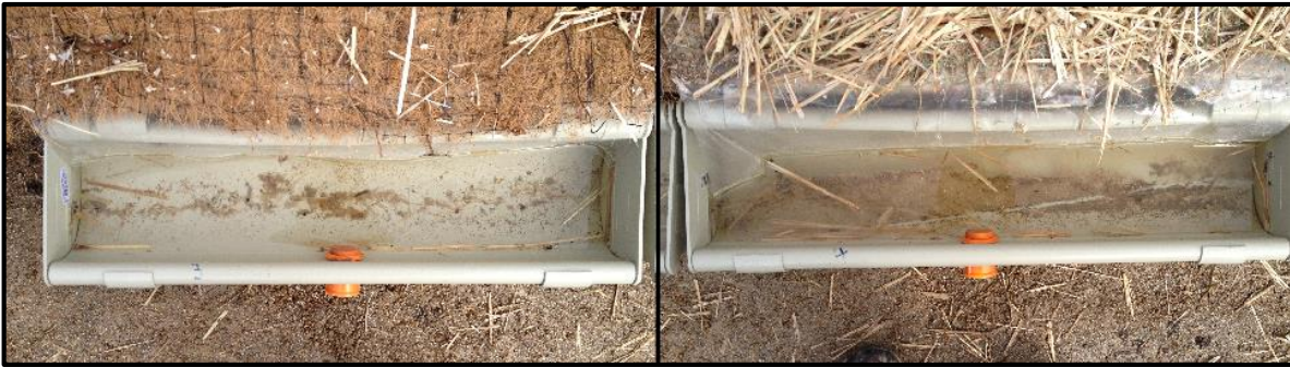
Figura C.8.3. Material arrastrado en un talud Hidrosechado con biomanto de fibra de coco y paja de trigo respectivamente
