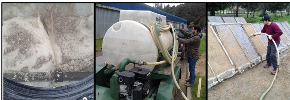
Figura 8. Proceso de hidrosiembra (Fuente: Elaboración propia)
