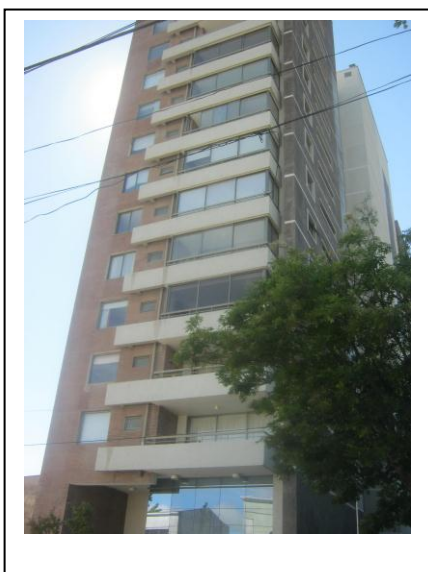
Fotografía digital N°3: Centro – Edificio en calle 18 de Septiembre
