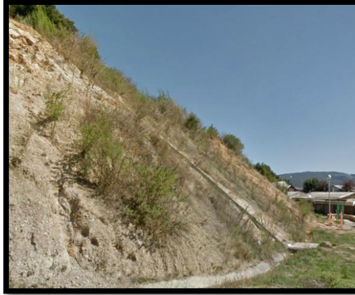
Figura N° 16: Vista General del Talud N° 002.
