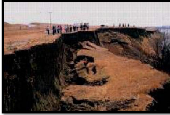
Figura N° 3: Deslizamiento de rotación.
