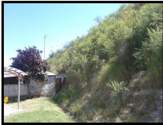
Figura N° 15: Vista General del Talud N° 001.
