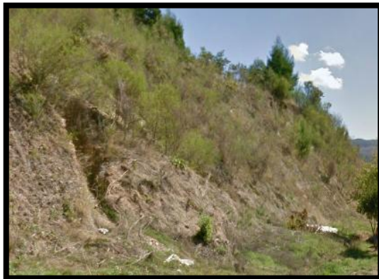
Figura N° 17: Vista General del Talud N° 003.
