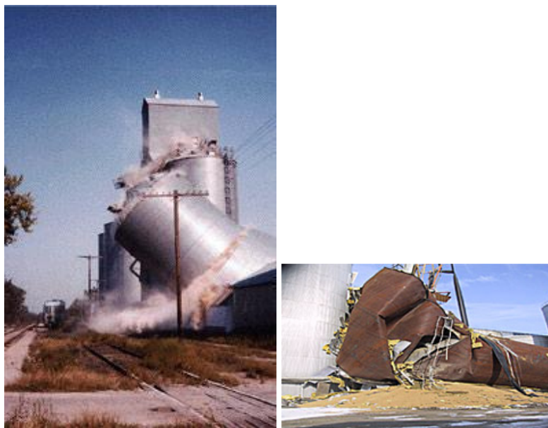
Figura 1.6: Colapso de silos de almacenamiento para material granulado.
