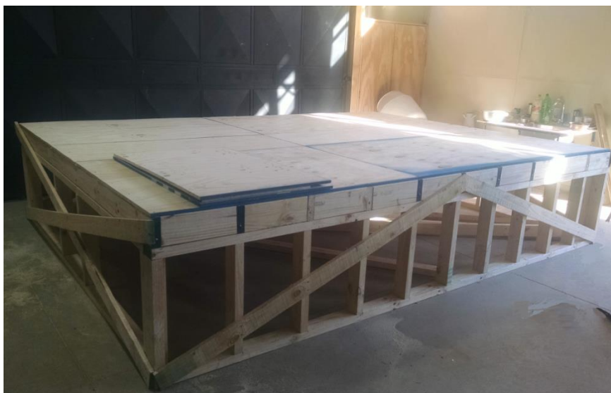
Figura 4. Fotografía del sistema de piso construido.
