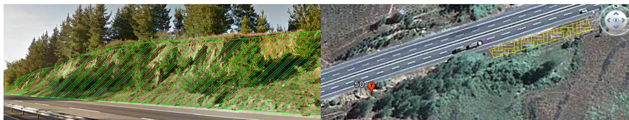
Figura I2. Condiciones Actuales y Vista en Planta del Talud 50.
