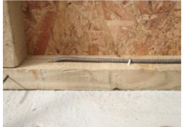
(b) Anclaje tipo “espárrago”
