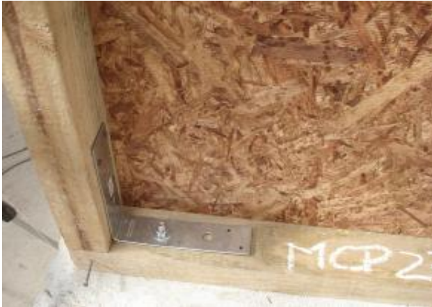
(a) Anclaje tipo perno-escuadra
