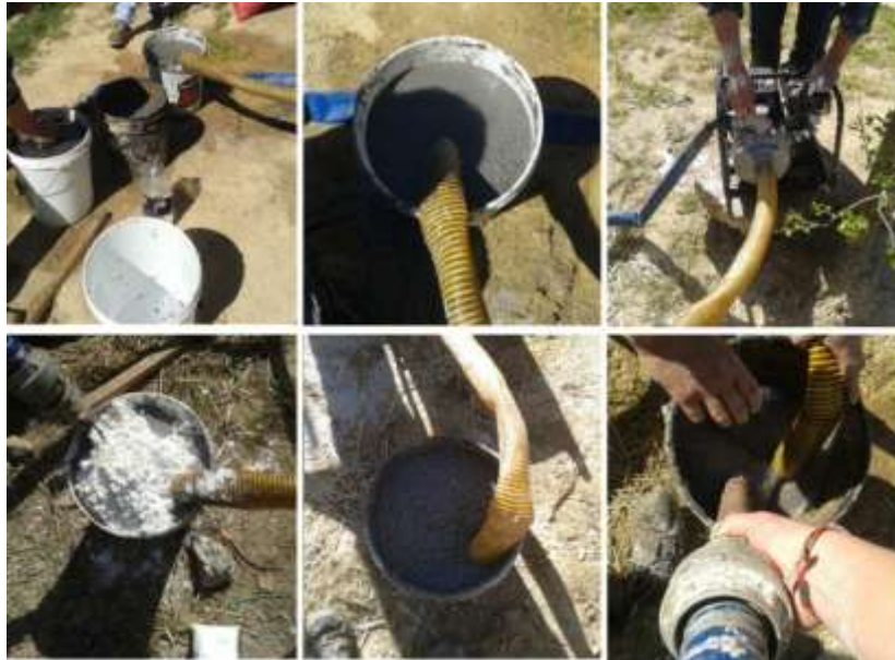
Figura D6: Proceso mezcla elementos de la hidrosiembra. (Fuente: Elaboración propia)
