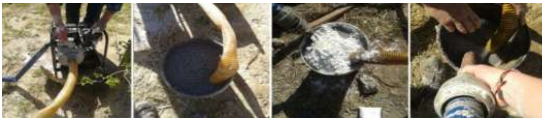
Figura 6. Incorporación de almidón a la mezcla de hidrosiembra.
