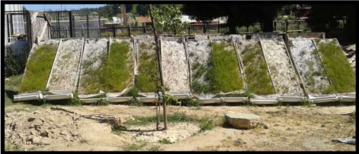
Figura D24: Cobertura semana 6 (Fuente: Elaboración propia)
