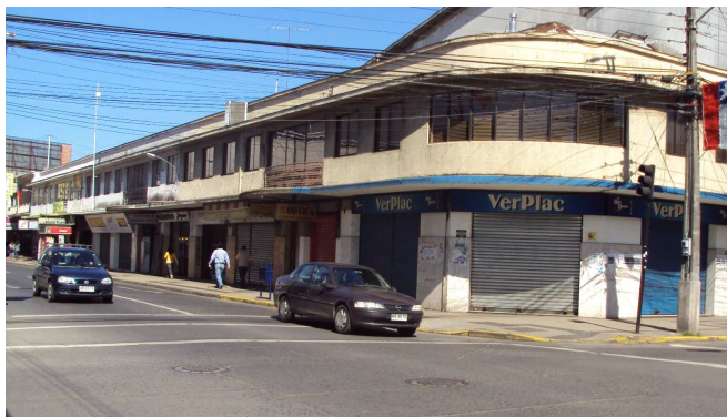
Fig. 37. Construcción en manzana-block Centro de Chillán
