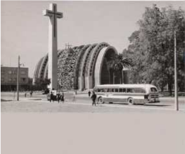
Fig. 34. Construcción de la Catedral.
