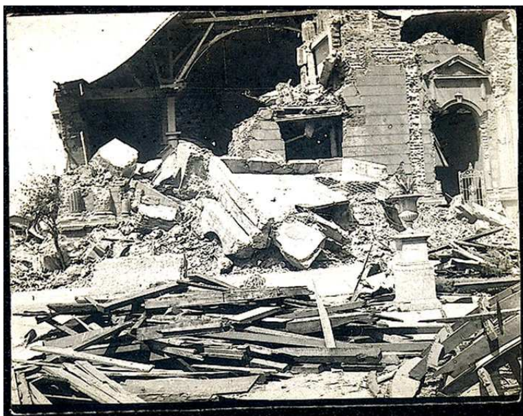
Fig. 33. Escombros de la Iglesia Catedral después del terremoto.
