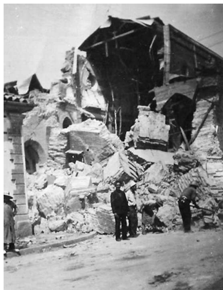
Fig. 6. Iglesia Santo Domingo destruida
