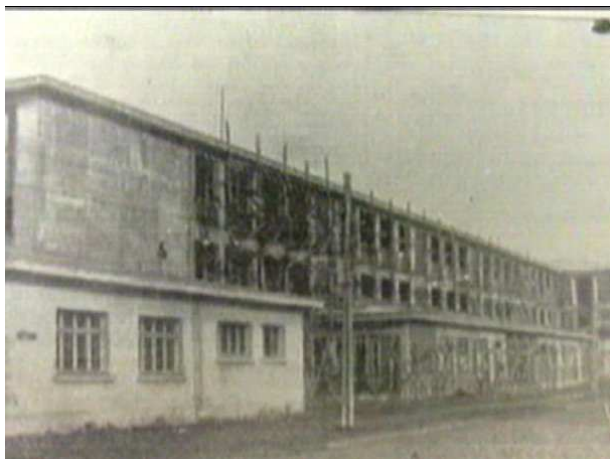
Fig. 22. Construcción del Liceo de Hombres, La Discusión 1947.
